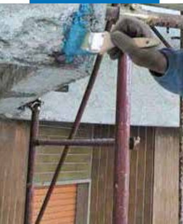
Нанасяне на Mapefer 1K с четка върху арматурни желяза по арматура на балкон
