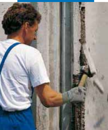
Отстраняване на разрушен бетон
