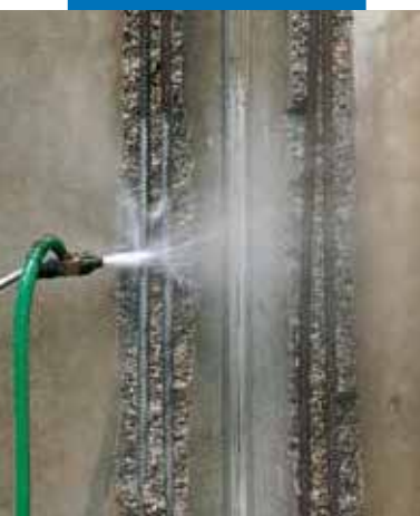
Почистване на арматурните желяза
