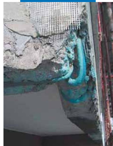
Арматурни жезла по челната страна на балкон, обработени с Mapefer 1K
